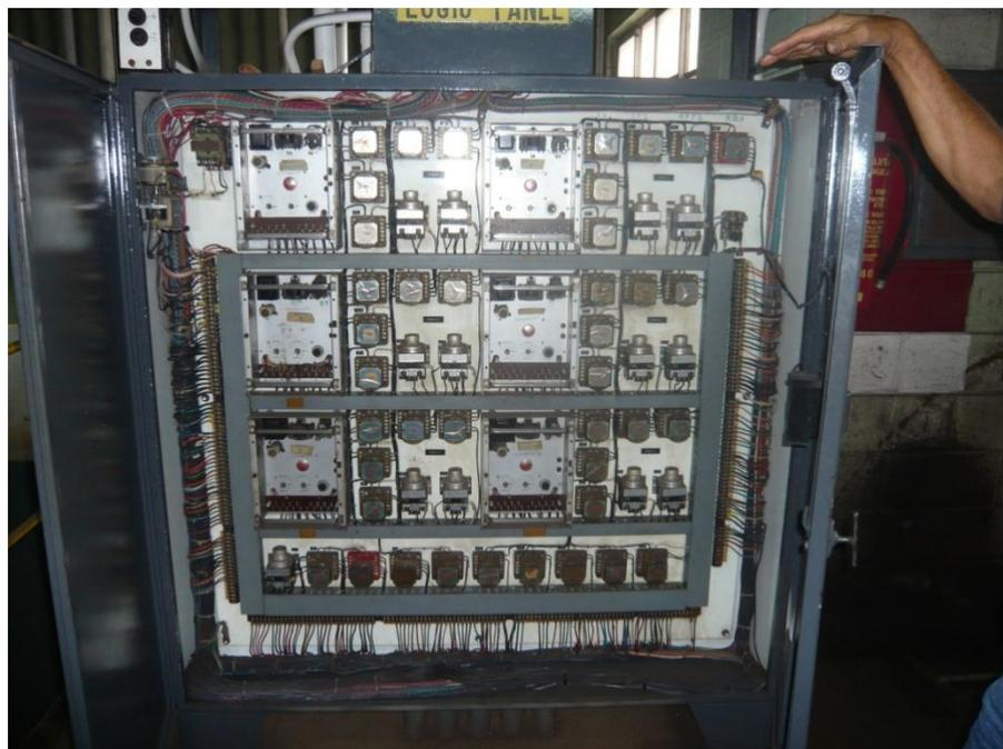
**Foto 11.5 A: Tablero Eléctrico sin Protección**
