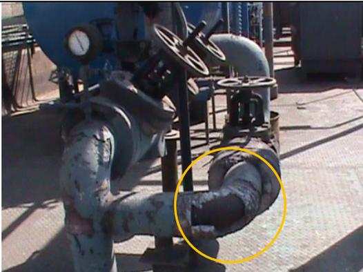
**Foto 11.12: Aislamiento de Asbesto Expuesto**
