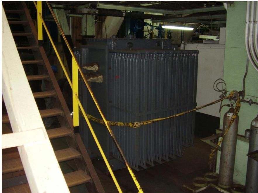
**Foto 11.4: Transformador si Malla Protectora**
