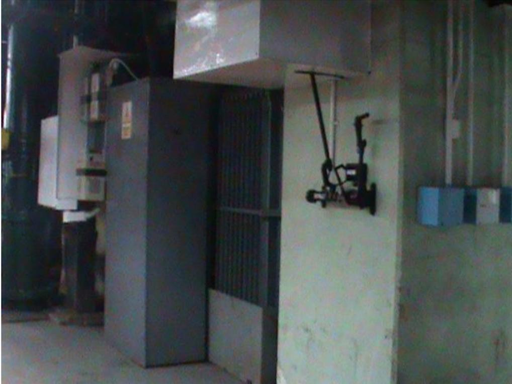
**Foto 9.2: Falta el Cerco de Protección al Transformador**
