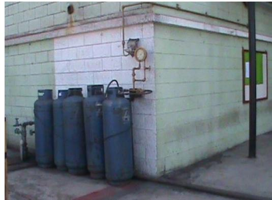
**Foto 11.13: Cilindros de gas propano sin Jaula Protectora**
