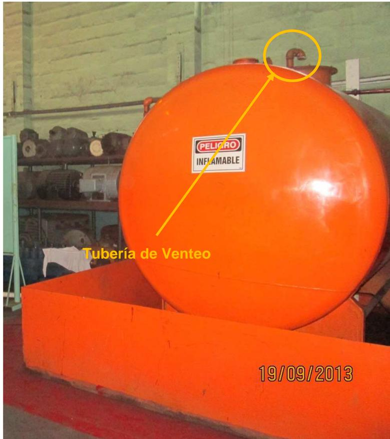
Foto 11.14: Tanque Diario Diesel con punto de Venteo Dentro de un Ambiente
