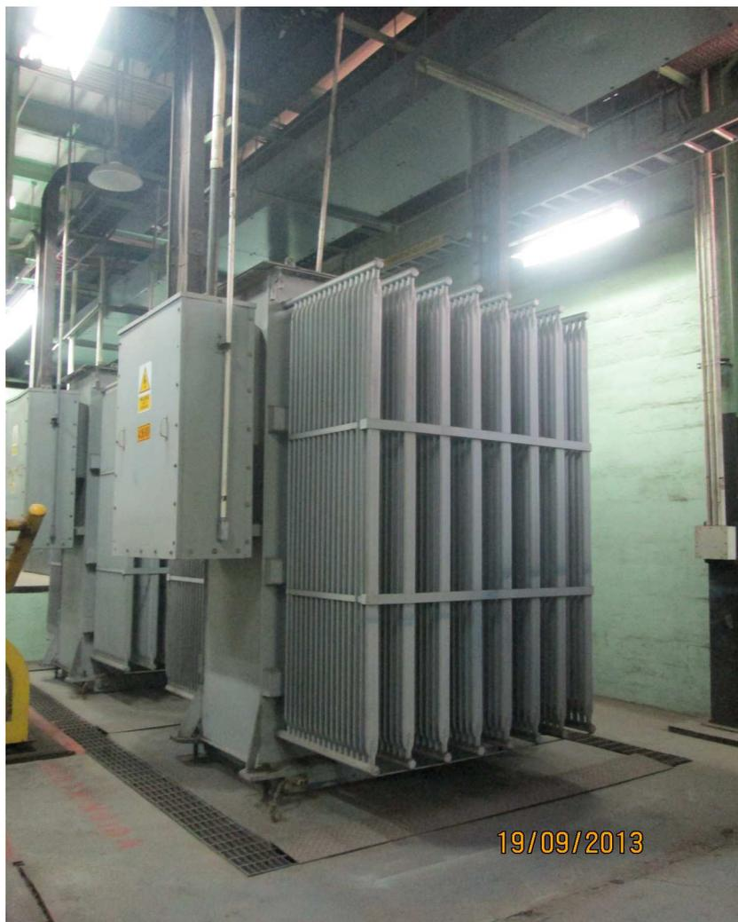
**Foto 9.2: Falta el Cerco de Protección al Transformador**
