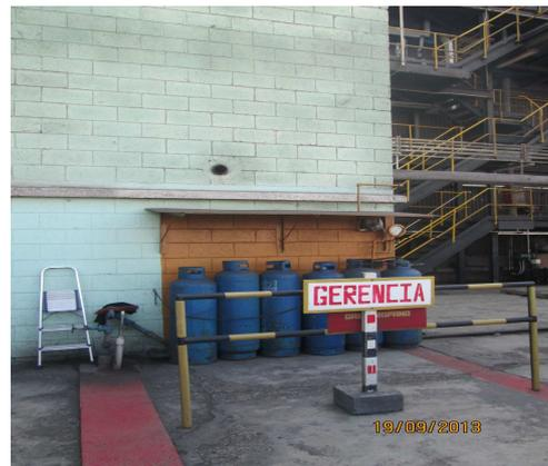
**Foto 11.13: Cilindros de gas propano sin Jaula Protectora**
