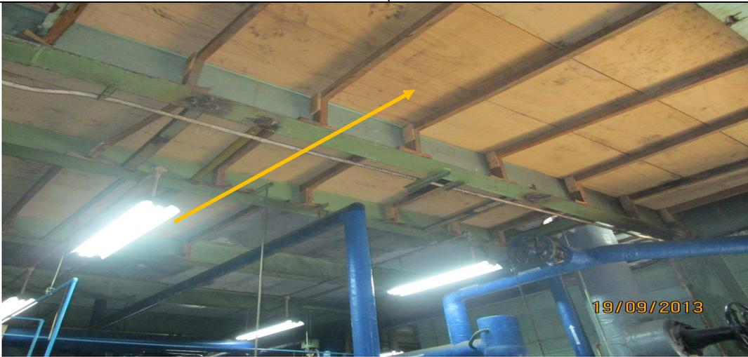
**Foto 11.11: Planchas de Triplay para evitar el desprendimiento de concreto**
