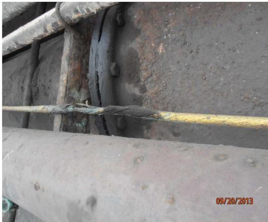
Foto 11.15: Cable de puesta a tierra para Sistema de Fuerza (sulfatado y corroído)
