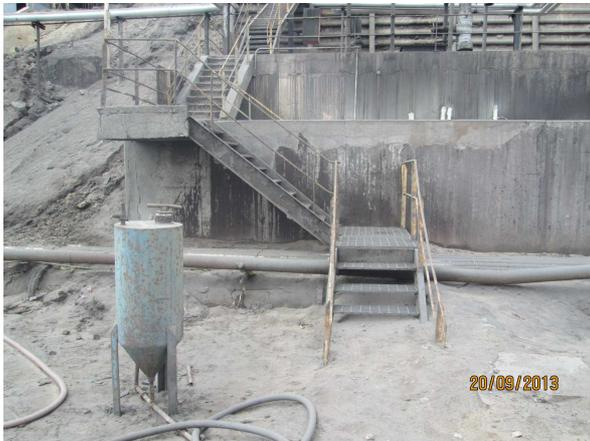
**Foto 11.7: Escaleras corroídas y deterioradas**
