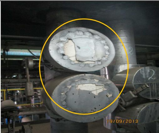
**Foto 11.12: Aislamiento de Asbesto Expuesto**
