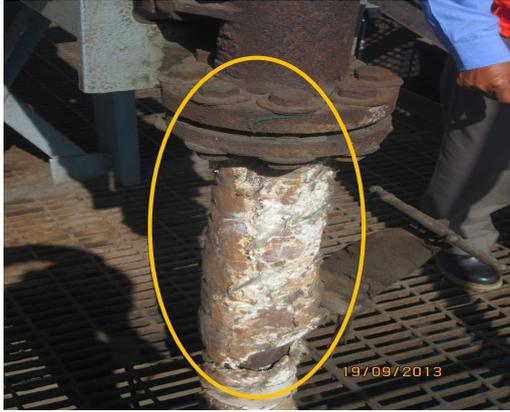
**Foto 11.9: Tubería Caliente Expuesta**
