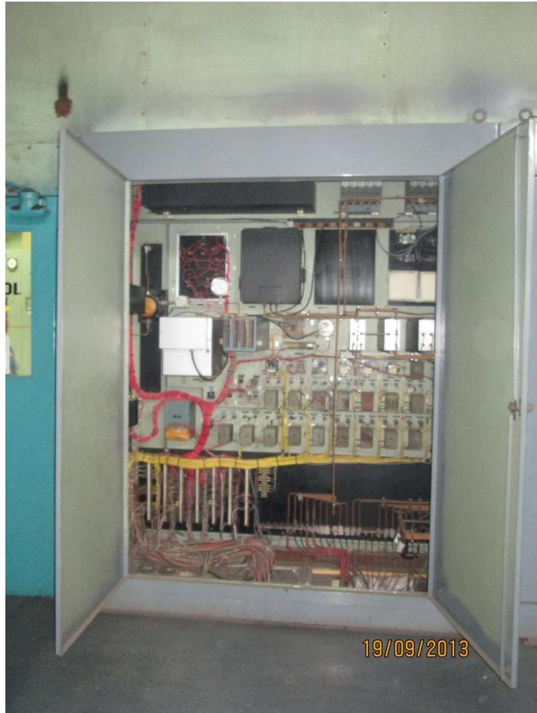
**Foto 11.5 B: Tablero Eléctrico sin Protección**
