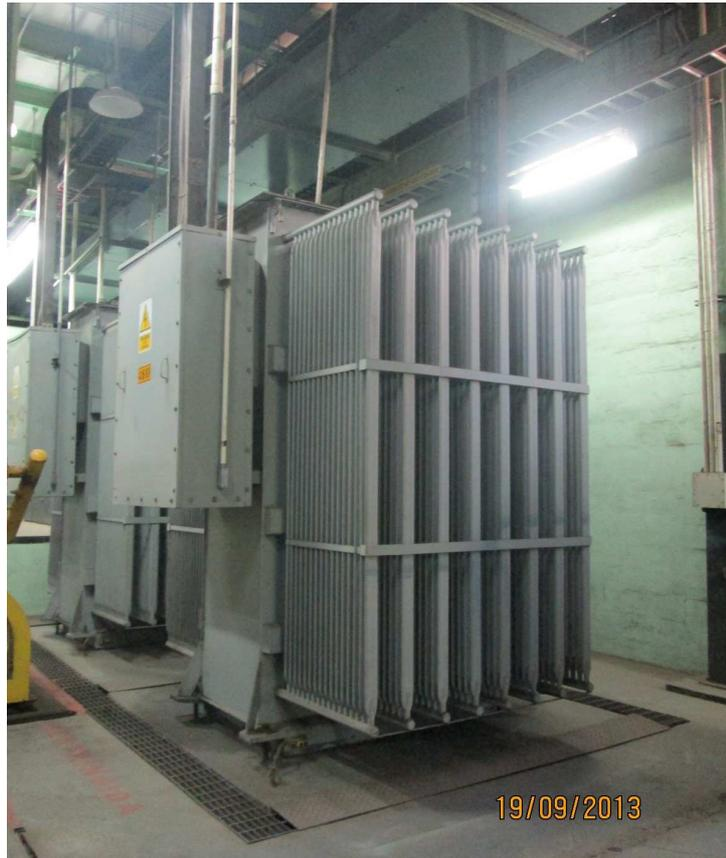
**Foto 11.4: Transformador sin Malla Protectora**
