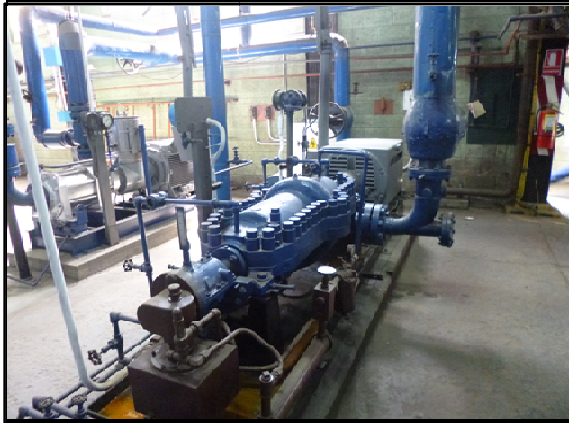
Foto N° 7. Una de las electro bombas anti-guas de carga de agua a los calderos.
