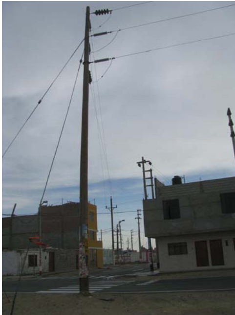
Figura N°1 . Vano P204-P205 con viviendas dentro de su faja de servidumbre.
