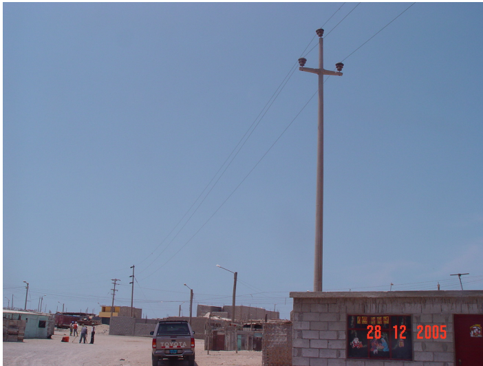
Figura N°1 . Construcción de viviendas bajo la línea de 34,5kV. Vano P183-P184
