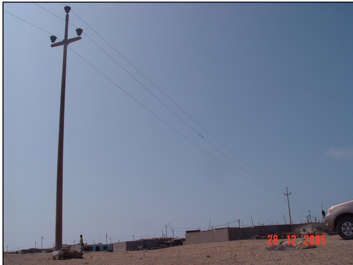
Figura N°1 . Construcción de viviendas bajo la línea de 34,5kV. Vano P182-P183
